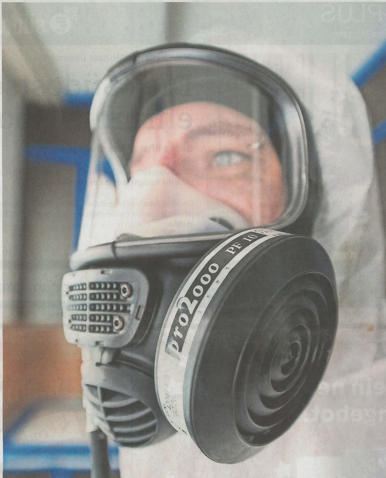
Schwarzone: Beim Ausbau von Fliesenplättli muss in einem abgesperrten Bereich mit Schutzkleidung gearbeitet werden. Bild Olivia Item
