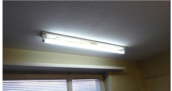
Abb. 1: Fluoreszenzlampe, die PCB-haltige Teile enthalten kann
