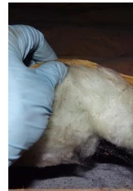
Abb. 3: Dämmung aus Mineralwollfasern (Glaswolle)
