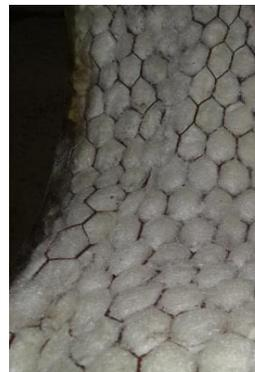
Abb. 2: Dämmung aus Keramikfasern
