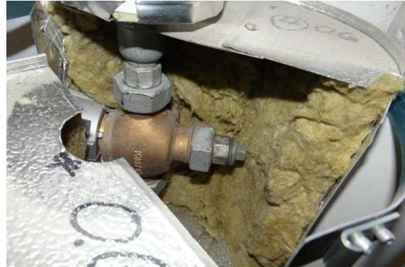
Abb. 1: Dämmung aus Mineralwollfasern (Steinwolle)
