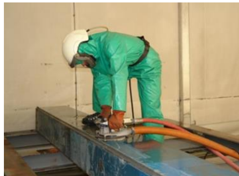
Abb. 6: HDW-Sanierung einer fixen Unterdruckzone
