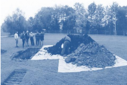
Bild 24: Altlastenuntersuchung (Quelle ETI)
