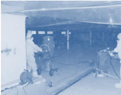
Bild 10: Entfernung PCB-belastete Betonfarbe (Quelle ETI)
