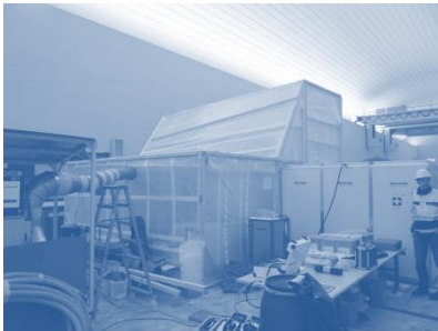
Bild 19: Sanierungszone (Quelle ETI)
