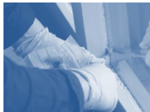
Bild 18: Probenahme Fensterkitt (Quelle ETI)
