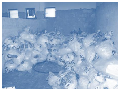
Bild 5: Zwischenlager mit Asbestabfällen (Quelle ETI)
