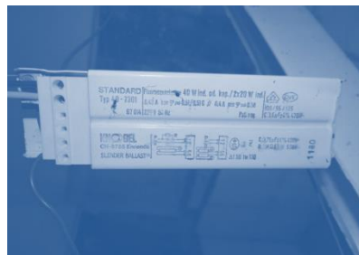
Bild 2: PCB-haltiges Vorschaltgerät (Quelle ETI)
