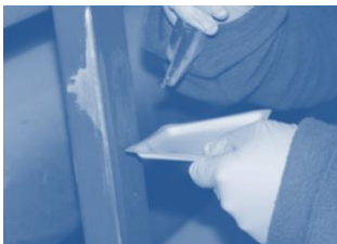
Bild 17: Probenahme Korrosionsschutz (Quelle ETI)
