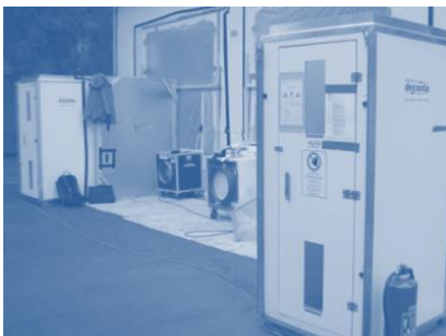
Bild 4: Eingangsbereiche Sanierungszonen (Quelle ETI)
