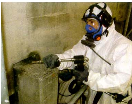
Sanierung in Chur
